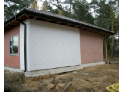
Dış Cephe Yalıtım
